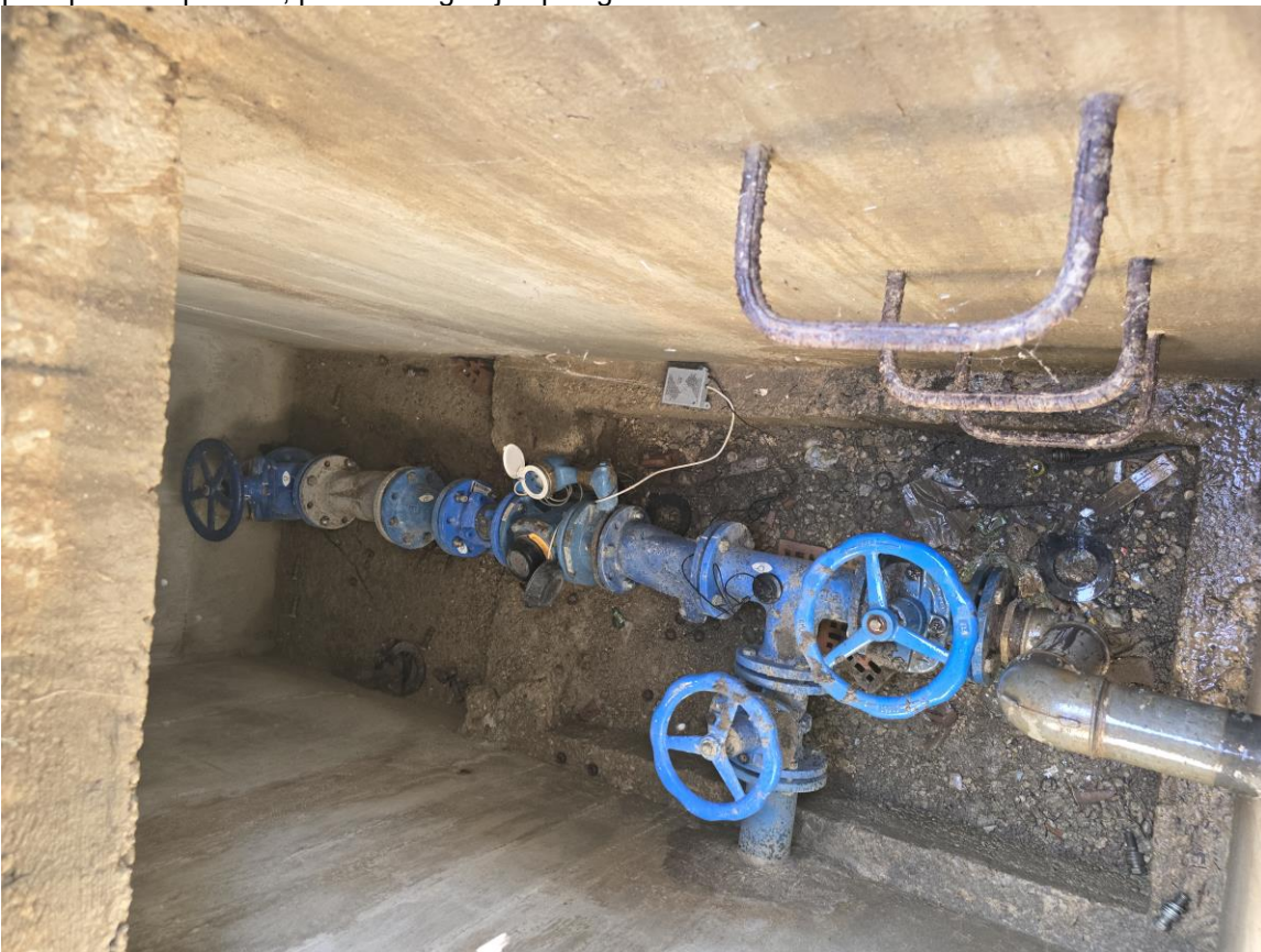
Postojeći priključni cjevovod iz PE-HD cijevi DN 110.
